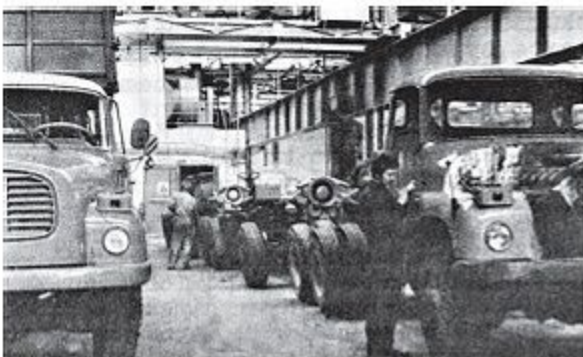
▲ Pohľad do montážnej dielne závodu Tatra v Pezinku s rozpracovanými vozidlami Tatra 148 po generálnej opravě (archív Vladimír Botta)
